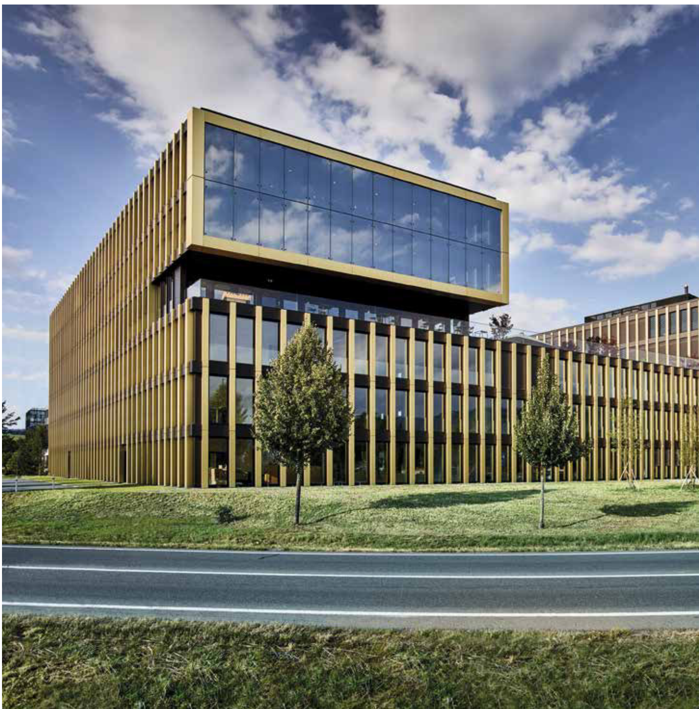
Die Beschattungslösung mit Siemens-Komponenten garantiert im Inneren des Quadrolith stets angenehme Temperaturen.
