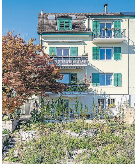
Mehr Natur und weniger Energie: Die Dämmung der Fassade der Doppelhaushälfte verändert das Erscheinungsbild des Gebäudes aus den 1930er-Jahren kaum.
