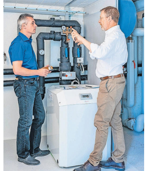
Energie-Coach Reto Niedermann (links) und Hausbesitzer Daniel Baumann vor der neuen Erdsonden-Wärmepumpe im Keller, die das Gebäude ohne fossile Energien heizt.
