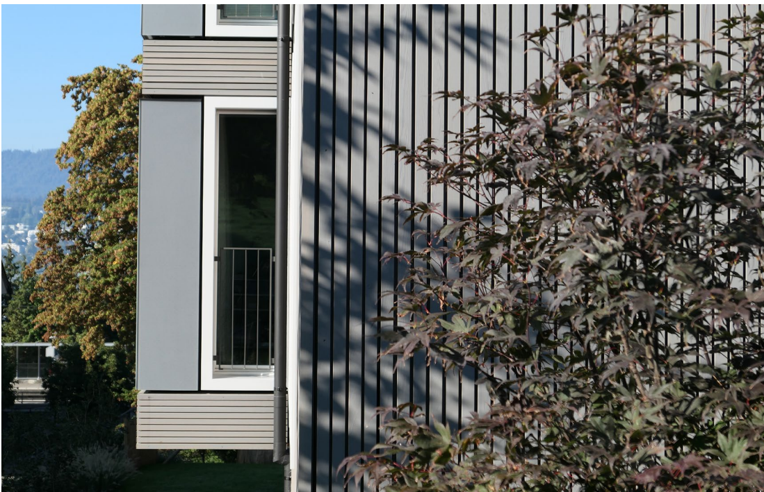
Mehrfamilienhaus Küssnacht mit grossen thermischen Sonnenkollektoren am Erker an der Südfassade, dachintegrierte Photovoltaik, Wärmepumpe mit Erdsonde, Null-Energie-Bilanz. Immeuble locatif à Küssnacht : grands capteurs solaires thermiques sur l'encorbellement de la façade sud, photovoltaïque intégrée aux toitures, pompe à chaleur avec sonde géothermique, bilan énergétique zéro.
