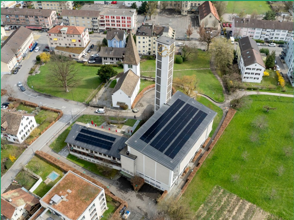
Das Zentrum Altstetten verfügt über die fortschrittlichste Energieversorgung der Kirchgemeinde. Eine Erdsonden-Wärmepumpe heizt die Gebäude und seit 2024 produziert die grosse Photovoltaikanlage auf der denkmalgeschützten Kirche Strom.
